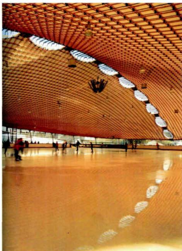
Malla de la cubierta de la pista de patinaje sobre hielo en Munich, 1985 (J. Schlaich y Ackermann).
