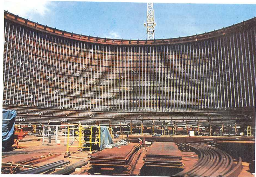
10. DETALLE DEL DEPOSITO INTERIOR de hormigón pretensado, de 80.000 metros cúbicos, de Barcelona (España), durante la fase de construcción. Se puede apreciar la camisa de acero, que asegurará la estanqueidad y que servirá de encofrado para hormigonar, luego, la pared. Los tubos verticales son las vainas por donde se enhebrarán luego los tendones de acero para el pretensado vertical de la pared.
