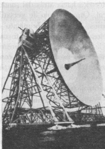
Fig. 9.—Gran antena orientable de 75 m. de diámetro en Jodrell-Bank (Manchester).
