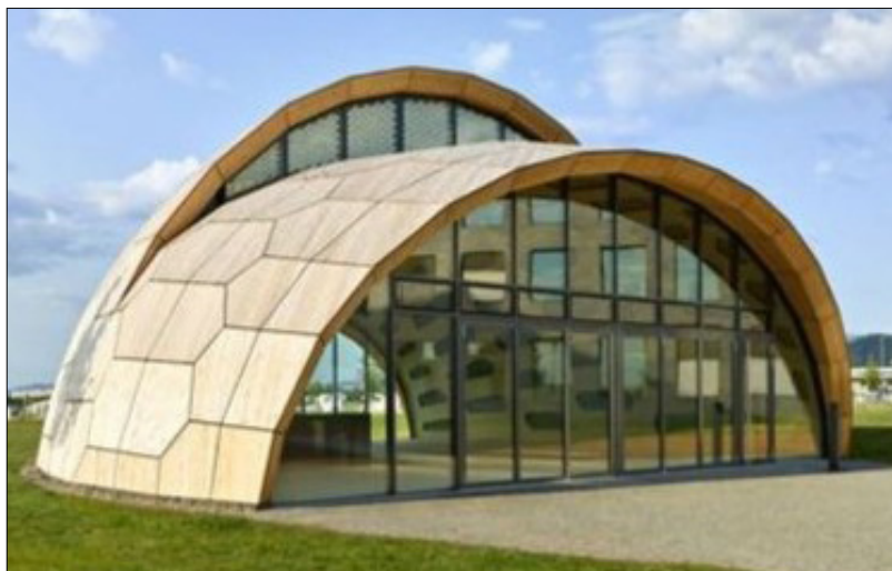
Figura 9. Cubierta con placas de madera imitando el caparazón de los erizos. (Cortesía de designboom )
