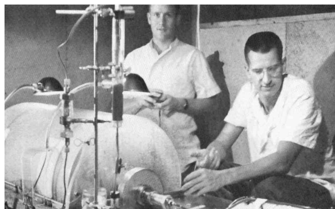
Figura 40. Tambor rotatorio a cuyo alrededor se enrollaban las membranas para el tratamiento de la hemodiálisis
