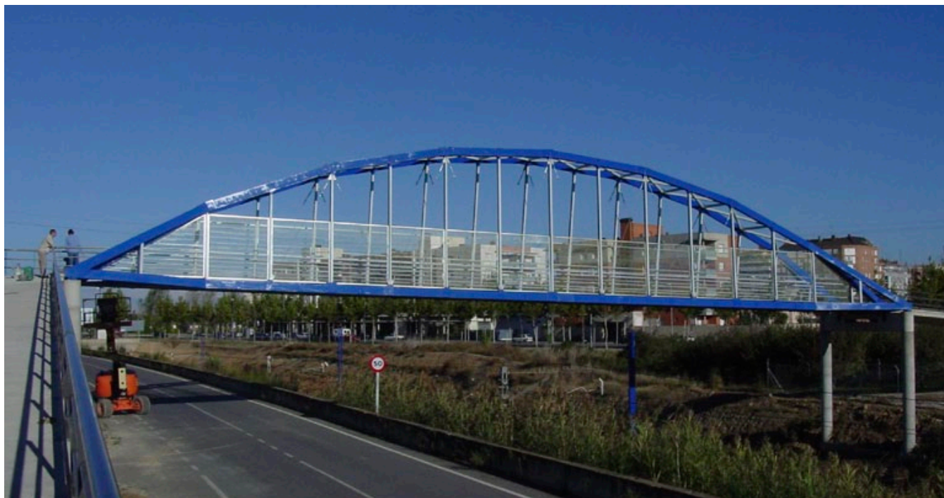
La pasarela de Lérida, primer puente construido en España con materiales compuestos, proyectado por Pedelta, S.L.
