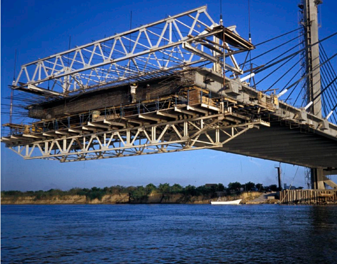
En las últimas décadas se han fabricado cementos que endurecen rápidamente y permiten desencofrar antes. De esta manera se hace posible la construcción por voladizos sucesivos con ciclos cortos que permiten reducir el tiempo de construcción de estos puentes. Puente de Papaloapan (México) (Carlos Fernández Casado, S.L.)(Cortesía Prof. Miguel A. Astiz).
