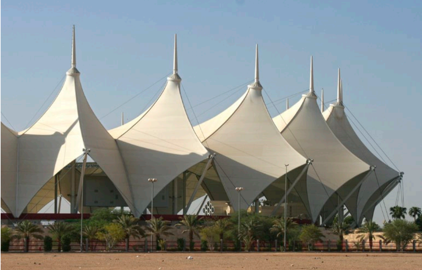
Cubierta de plástico del estadio internacional Rey Fahd de Riad (Arabia Saudí).
