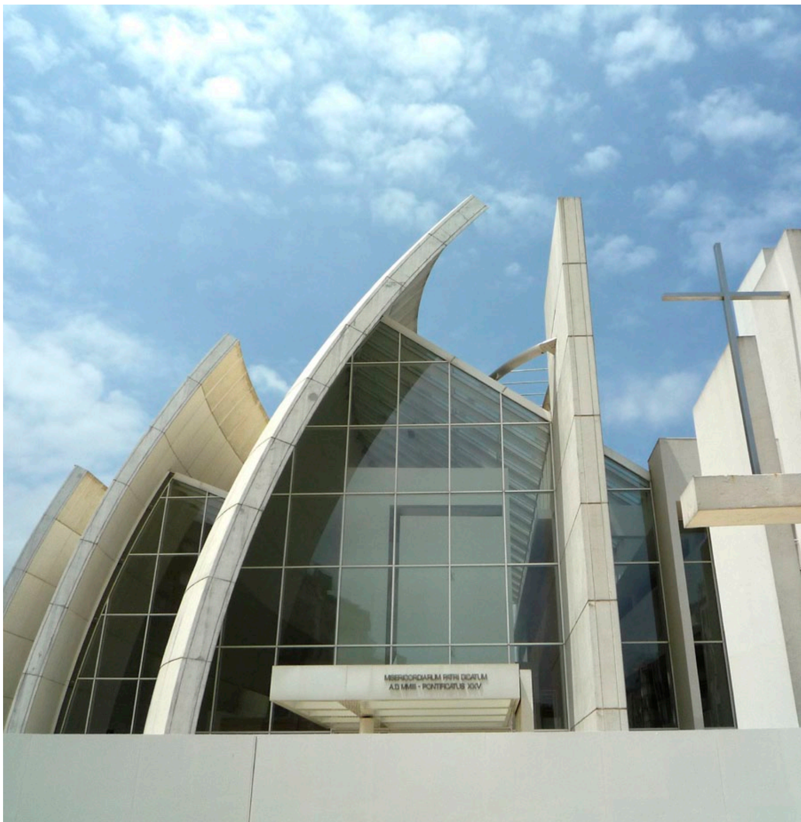
Estructura de hormigón auto-limpiante en el que se han introducido partículas de \text{TiO}_2 . Iglesia en Roma de Richard Meier, 2003.
