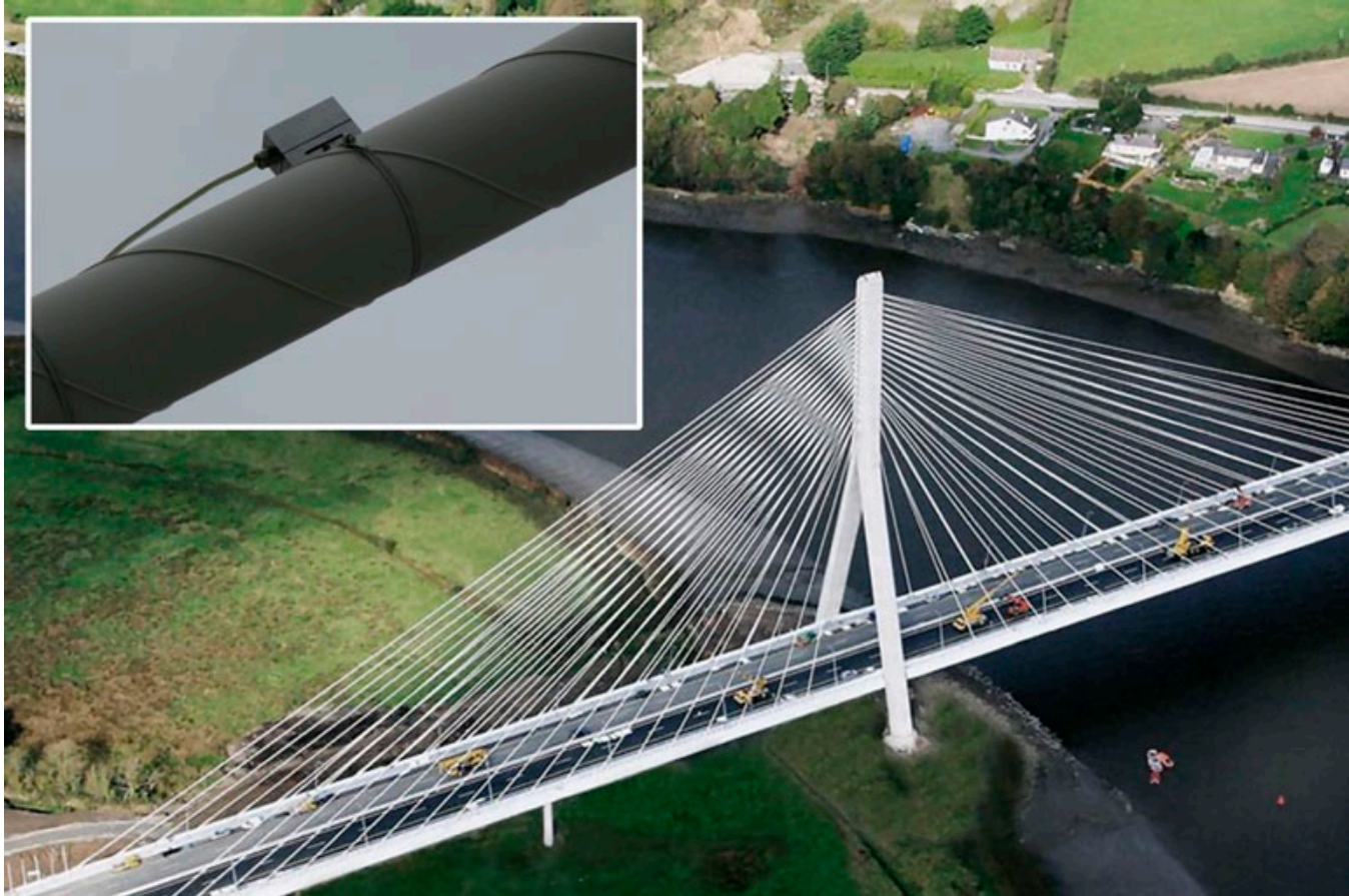
El puente atirantado de Waterford (Irlanda) tiene varios tirantes instrumentados para controlar las vibraciones producidas por el viento. (Proyecto de Carlos Fernández Casado, S.L.) (Cortesía Prof. Miguel A. Astiz).
