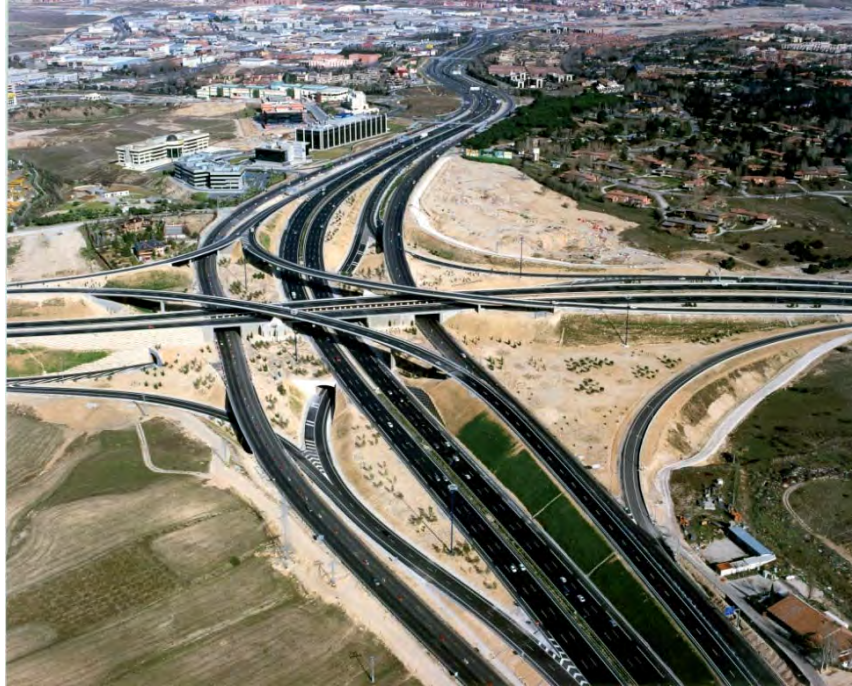
Figura 35: Enlace M-40 con N-I, Madrid mostrando puentes curvos.
