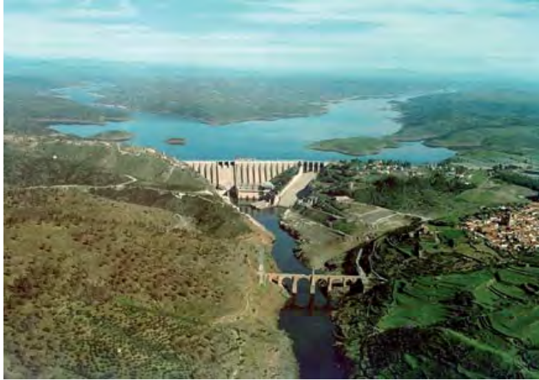
Figura 34: Puente y presa de Alcántara en Cáceres mostrando cómo se busca la perpendicularidad de los puentes y las luces mínimas.
