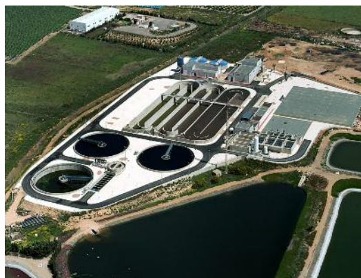
Depuradora de Los Alcázares
