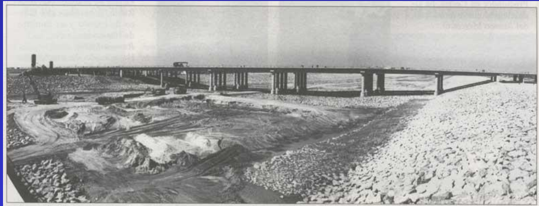
PUENTE SOBRE NUEVO CAUCE DEL TURIA (VALENCIA)
