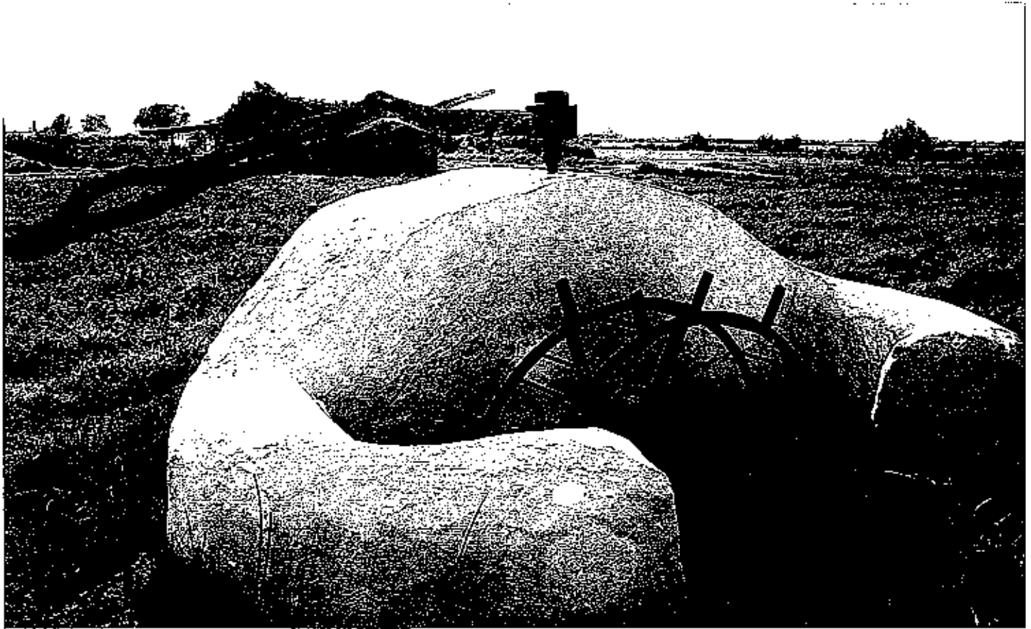
Fotos 5 y 6. Antiguo pozo somero equipado con una noria con fines de drenaje (foto C. Loaso).
