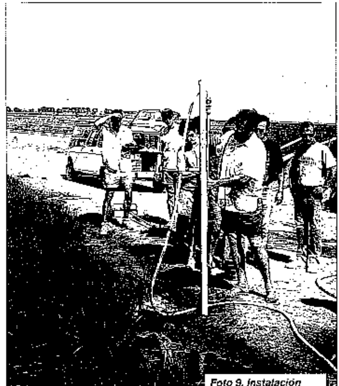
Foto 9. Instalación de un tubo de observación en el acuífero superior en el área de Mitjorn como una práctica de estudio del Curso Internacional de Hidrología Subterránea, utilizando una lanza de agua (foto E. Custodio).
