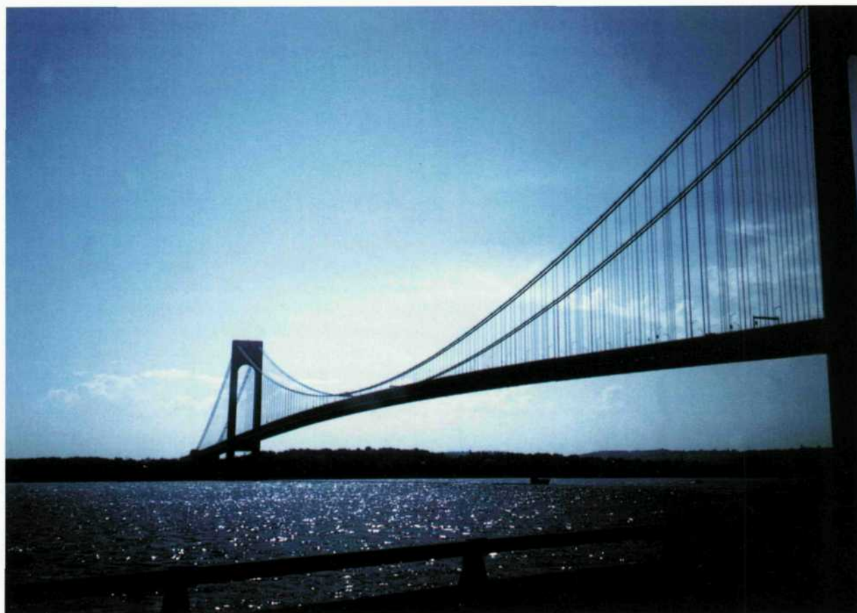
Fig. 5. — Puente colgante fabricado con fibras metálicas. El puente de Verrazano (EE. UU.) —con una luz de 1.298 m— fue récord mundial de puentes colgantes desde 1964 hasta 1981 (foto de M. Elices).
