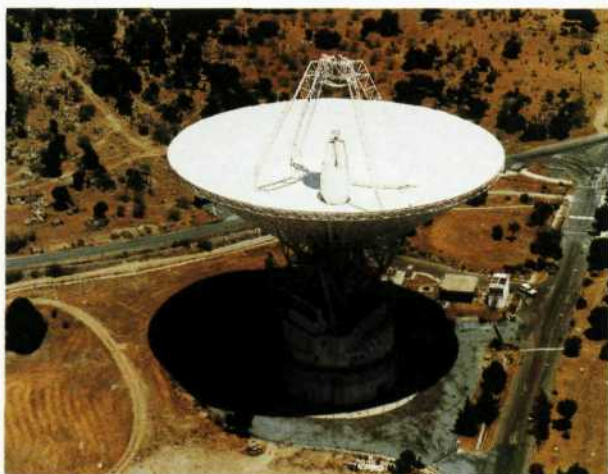
Fig. 3.- Vista aérea de la gigantesca antena de 70 m de diámetro de la Estación de Robledo de Chavela (Madrid), que permite recibir señales extremadamente débiles desde los confines del Sistema Solar.
