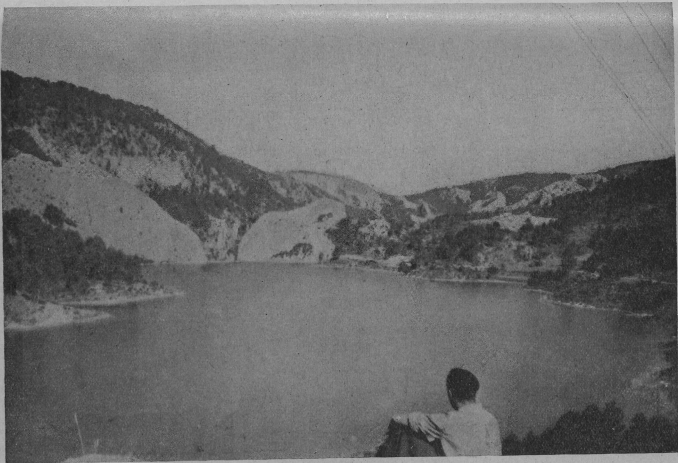
Fot. 2.—Embalse de Santa Cristina, en el río Guadiela. Las rocas que forman la cerrada son calizas, como puede reconocerse, por su típico aspecto, en la fotografía. La construcción del embalse fué posible porque un detenido estudio geológico previo descubrió que estas rocas están respaldadas por unas margas impermeables.
