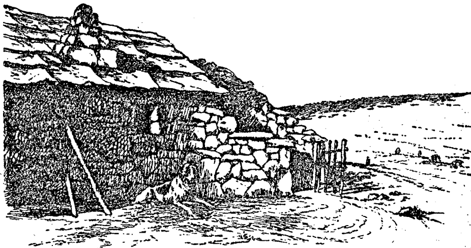
Fig. 2. — La cabaña de Los Lagos, en las vertientes septentrionales de la Sierra de Híjar. Construcción sencilla de mampostería en seco y techo de grandes lajas de areniscas triásicas, sobre rollizos de madera.
