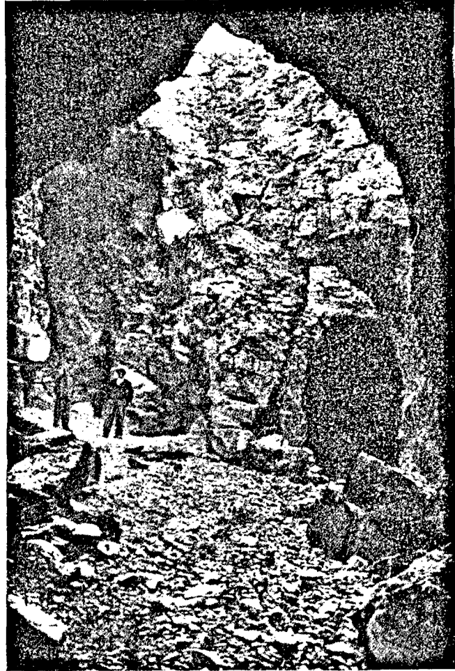
Fig. 287.—Interior de las canteras de caliza de Colmenar de Oreja (Madrid).
