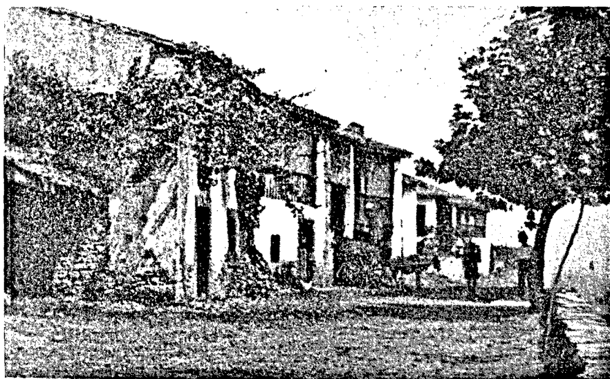
Fig. 158.—Construcciones urbanas campesinas; en Buelna (Asturias oriental).
