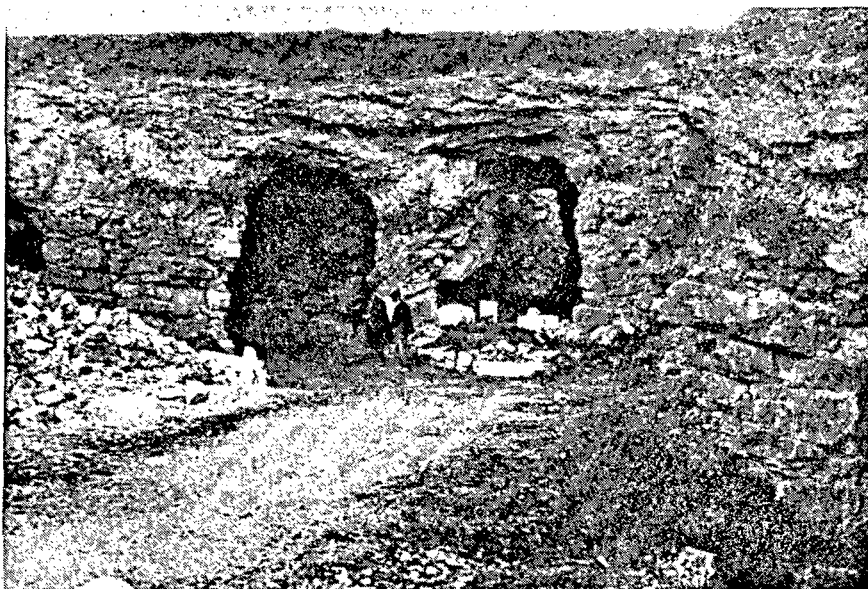
Fig. 252.—Cantera de caliza blanca, miocena, de la zona alta de los páramos, en Colmenar de Oreja (Madrid), explotada con intensidad para la obtención de bloques con destino a los grandes edificios de la capital, en el siglo XVIII.
