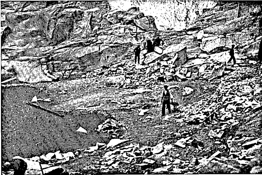
Fig. 251.—Explotación del granito como material de construcción en una cantera de las inmediaciones de Alpedrete (Madrid), en la base de la Sierra de Guadarrama.
