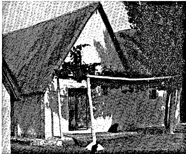
Fig. 367.—Construcción típica de la Huerta de Valencia, en la zona inmediata a la Albufera. (Foto Hernández-Pacheco, junio 1939.)
